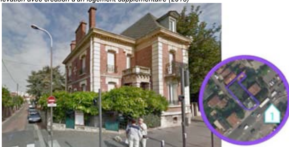
Extension et réhabilitation d'une annexe en logement (2014)
