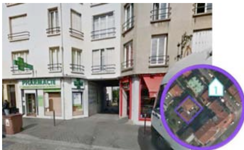
Création d'un logement avec modification de façade (2014)
