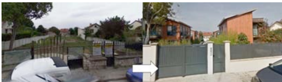
Exemple de dent creuse bâtie avec opération de maisons individuelles groupées
