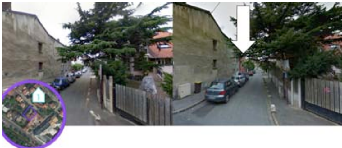
Conversion d'un hangar et d'un entrepôt en logement (2010)
