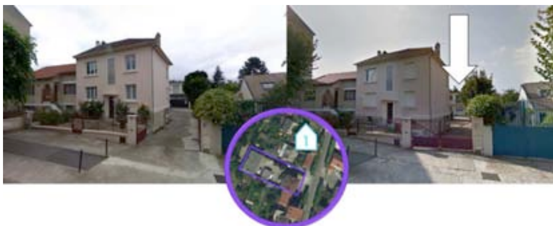
Transformation d'un local existant en habitation (2011)
