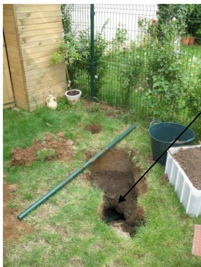
*Photo 14 : incident dans un jardin privatif en liaison avec un puisard d'eaux pluviales au-dessus d'une carrière de gypse (photo AML-IGC) - Villejuif*
